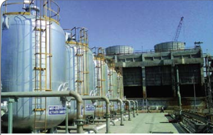
الشكل (1-3-6-29) c : المرشحات الرملية ISTP، Jamnagar، India
