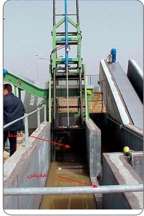
الشكل (3-2-4) مصفاة ذات قضبان خشنة شاقوليه آلية
