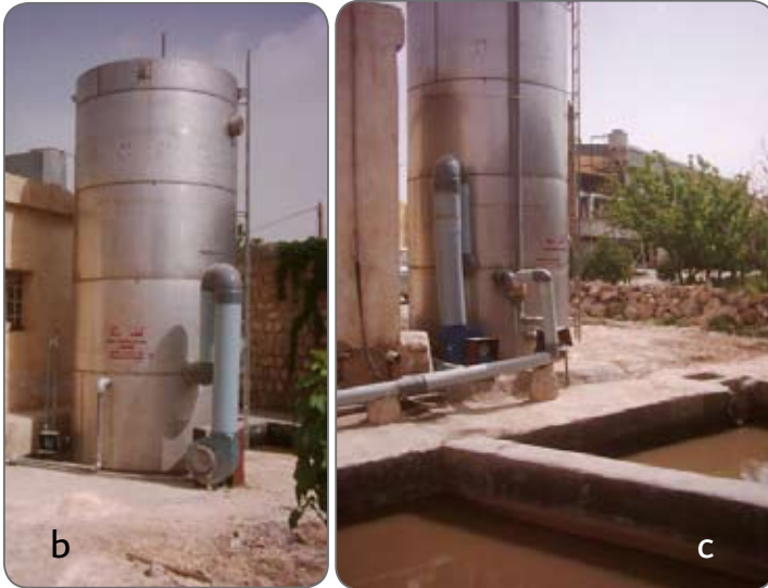
(تابع) الشكل (1-3-3-21) a مبدأ عمل المرشح b المرشح c حوض التوازن وفصل الزيوت
