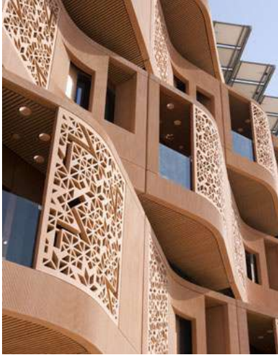
شكل (٢- ٢٨) معالجة الحوائط في إحدى المباني
