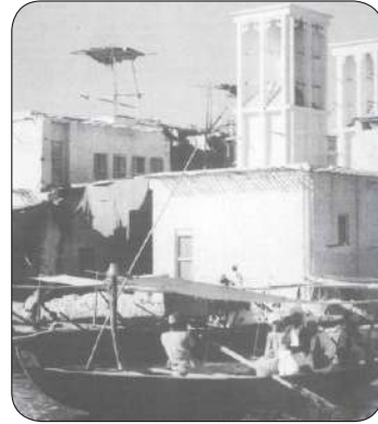
شكل (٣- ٣١) البادجير او البارجيل عنصر مناخي مهم ومتكرر استعماله في العمارة التقليدية في ابوظبي
