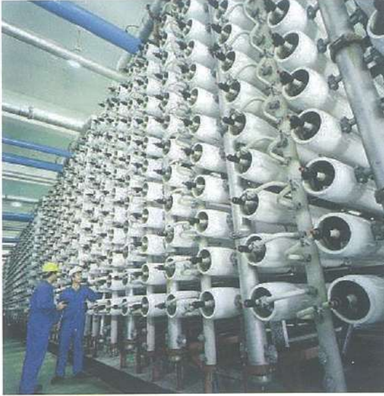
الشكل ٦٩: صورة لمحطة تحلية تعمل بطريقة التناضح العكسي.
