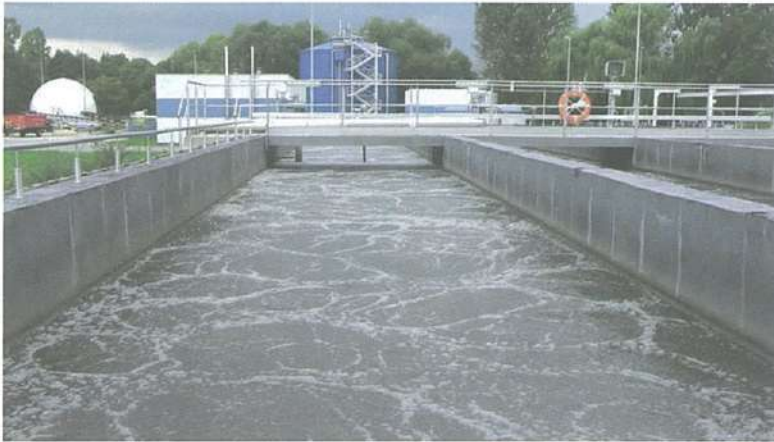
الشكل ٣٨: أحواض التهوية في محطة معالجة مياه الصرف الصحي.
