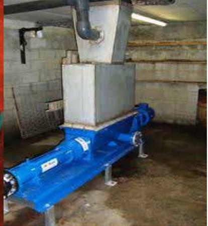
الشكل (a,b,c,1-2-3-1) المضخة ذات الحركة التقدمية PC
