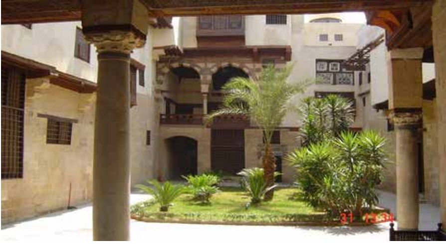
شكل (2-3) المسطحات الخضراء داخل بيت السحيمي تساهم في عمليات التحكم في درجة حرارة البيئة الداخلية للبيت(الباحث)
