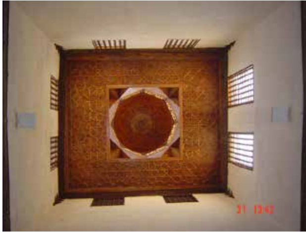
شكل (1-13) دور الشخشيخة داخل بيت السحيمي كعنصر فعال في سحب الهواء كأحد المعالجات المناخية
