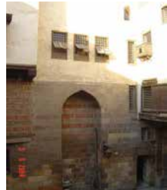
شكل (4-31) الواجهة الجنوبية
